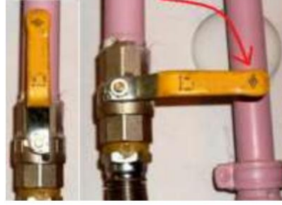
Doğalgaz vanasının açık ve kapalı konumu
